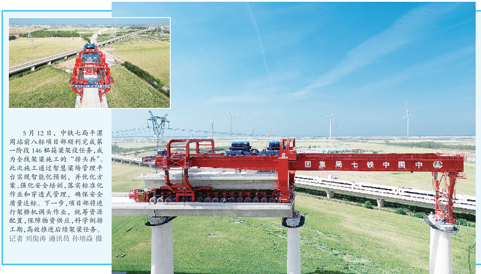
5月12日,中铁七局平深周站前八标项目部顺利完成第一阶段146根箱梁架设任务,成为全线架梁施工的“排头兵”。
